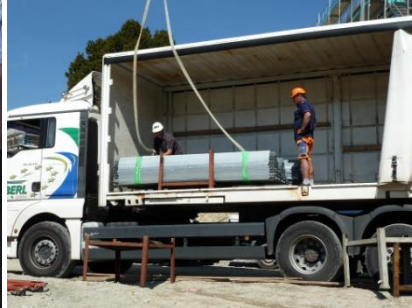
décharger par grue ou chariot élévateur
