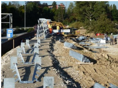
mettre en place des supports
