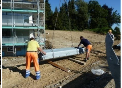
pose de matériaux
