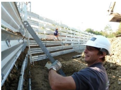
pose de traverses horizontales
