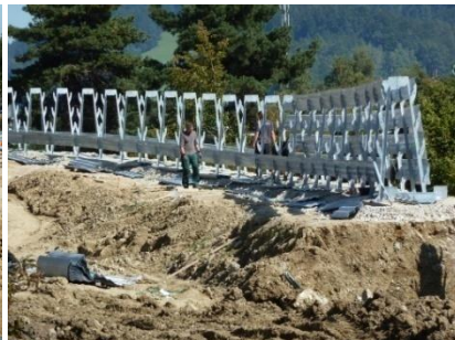
accrocher des modules latéraux
