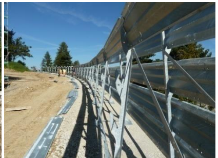
les modules latéraux sont fixés
