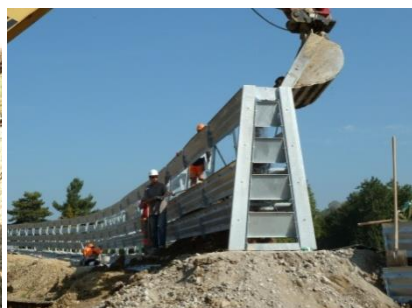
remplissage par pelleteuse -
